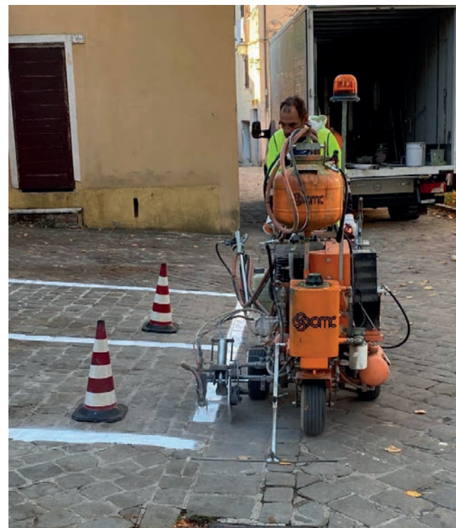
Rifacimento della segnaletica orizzontale
